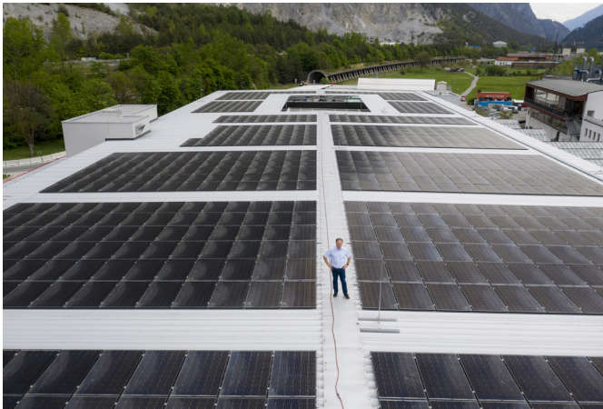
332 PV-Module wurden neu montiert.
